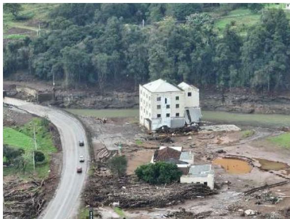
Figura 16- Imagem de voo de drone realizado por equipe do SGB após o evento de 2024, durante atividades de pós desastre. Planície do rio Jacaré no setor RS_ENCANTA_SR_013_SGB.
