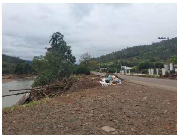
Figura 18- Ocupações próximas à margem erosiva do arroio Jacarezinho no setor RS_ENCANTA_SR_018_SGB.
