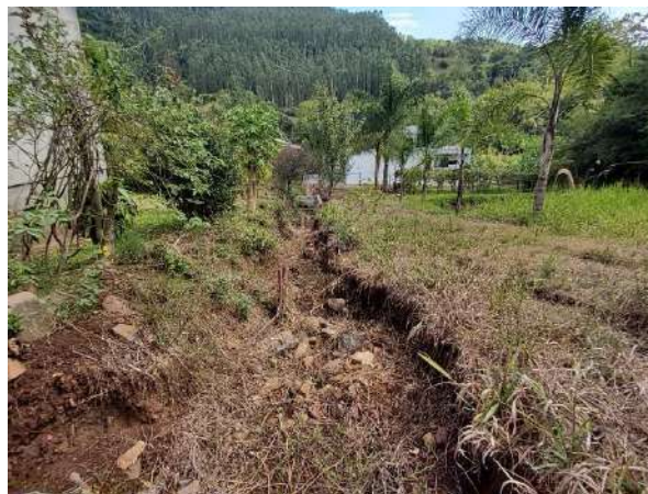
Figura 21- Destaque para a continuação da ravina, com uma caixa de captação de drenagem realizada próximo ao terreno da outra moradia no setor RS_ENCANTA_SR_017_SGB.
