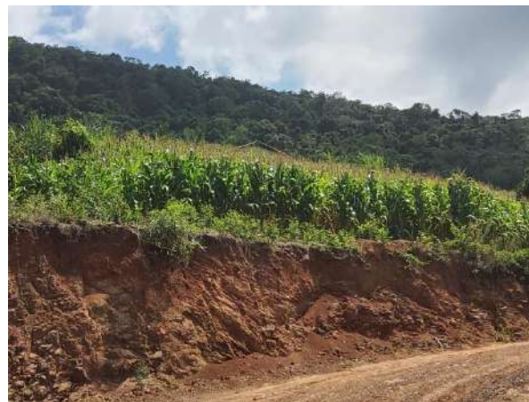
Figura 11- Corte de estrada, em encosta com suscetibilidade natural a movimentos de massa, no setor RS_ENCANTA_SR_008_SGB.
