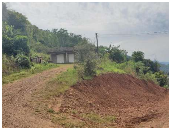
Figura 10- Corte de estrada, em encosta com suscetibilidade natural a movimentos de massa, próximo a moradia no setor RS_ENCANTA_SR_015_SGB.
