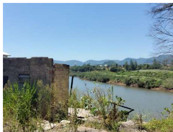
Figura 19- Ocupações próximas à margem erosiva do rio Taquari no setor RS_ENCANTA_SR_039_SGB.
