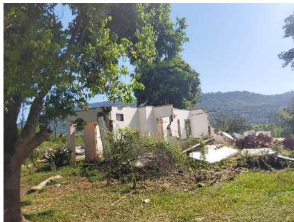
Figura 17- Ocupação atingida no evento de 2024, completamente destruída na comunidade Barra do Jacaré. Setor RS_ENCANTA_SR_001_SGB.
