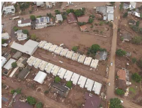
Figura 14- Imagem de voo de drone realizado por equipe do SGB após o evento de 2024, durante atividades de pós desastre. Setor RS_ENCANTA_SR_020_SGB.
